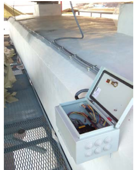
Рисунок 4. Смонтированные инклинометры на объекте мониторинга
