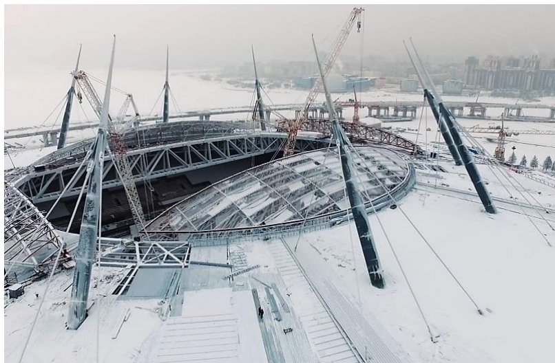
Рисунок 1. Внешний вид крыши на этапе строительства
