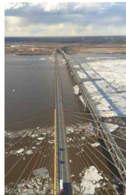
Рисунок 2. Вид с пилона на мостовое сооружение через реку Обь в районе Сургута
