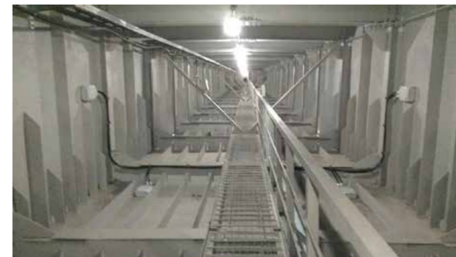
Рисунок 3. Размещение тензометров и акселерометров внутри пролетного строения
