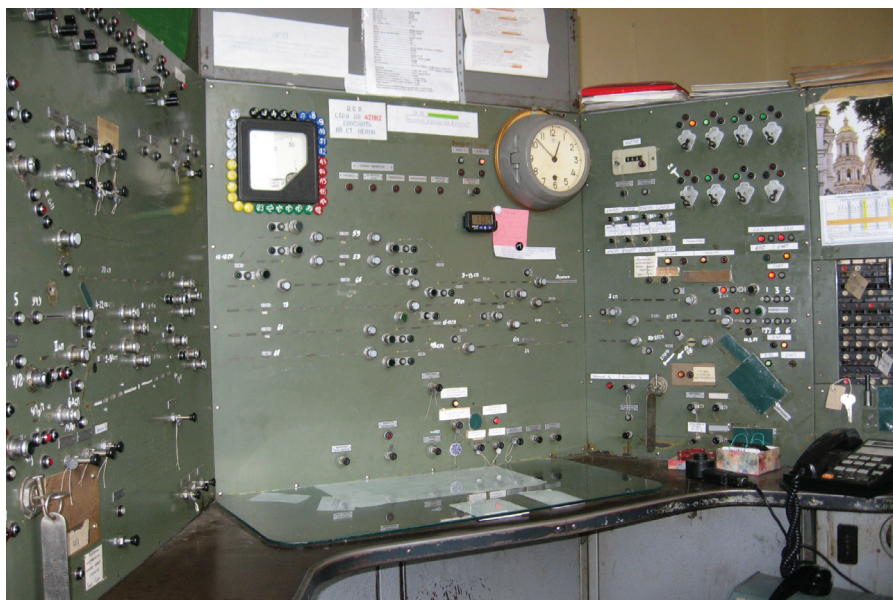
Пульт-табло релейной системы управления движением поездов (1964 г. внедрения, ст. Горы Октябрьской ж.д.).
