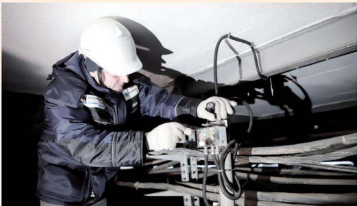
В подпольях размещают датчики температуры, влажности и атмосферного давления, а также скважины с термокосами
